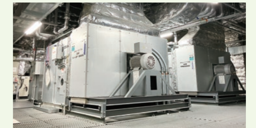
運用方法の見直しで、運転時間の削減に成功した空調機
